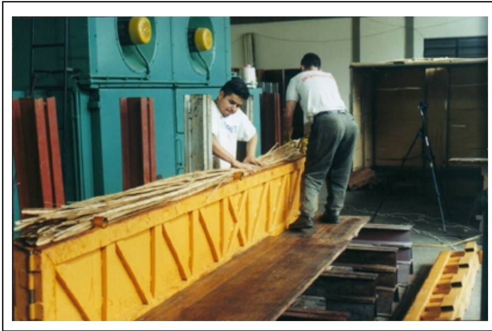
FIGURA 3. Tiras encoladas dentro del encofrado
