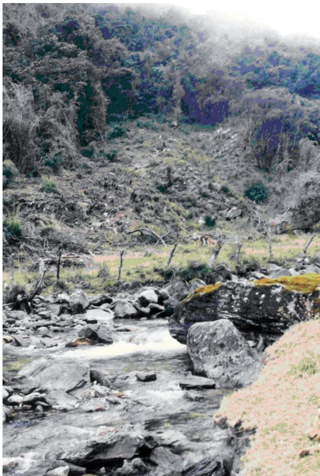
Figura 6. Deslizamiento adyacente a carretera y cauce del río
