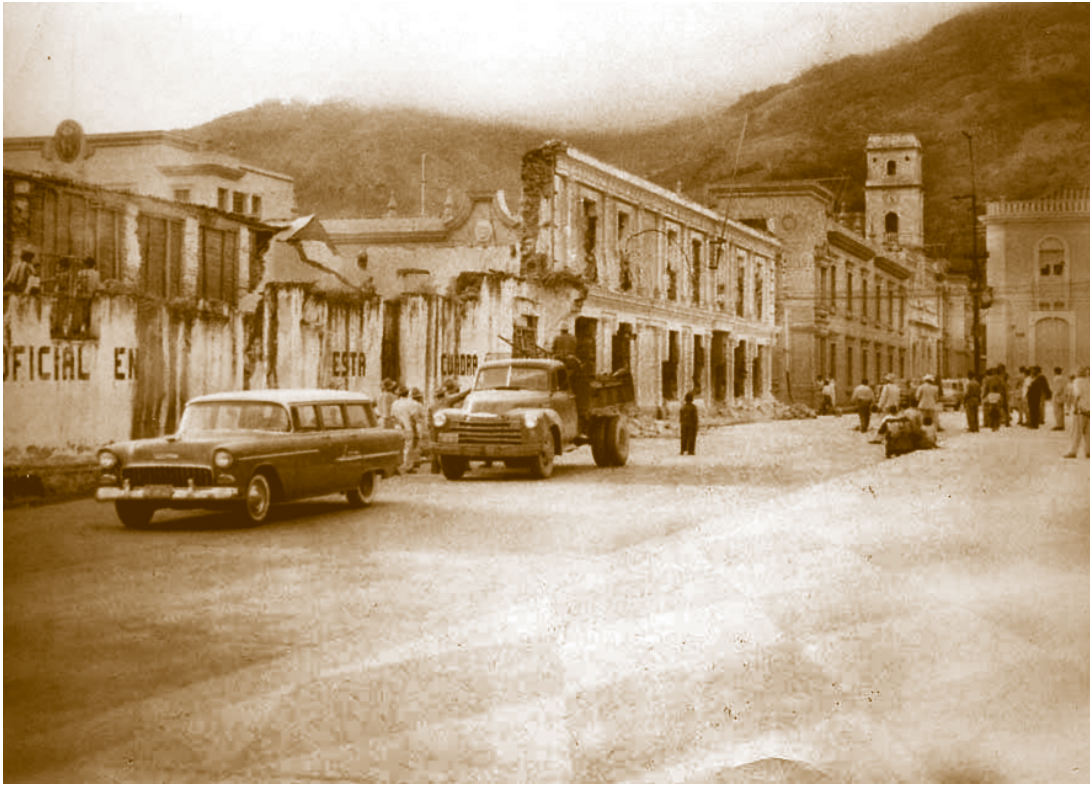
Demolición de la Antigua Gobernación
