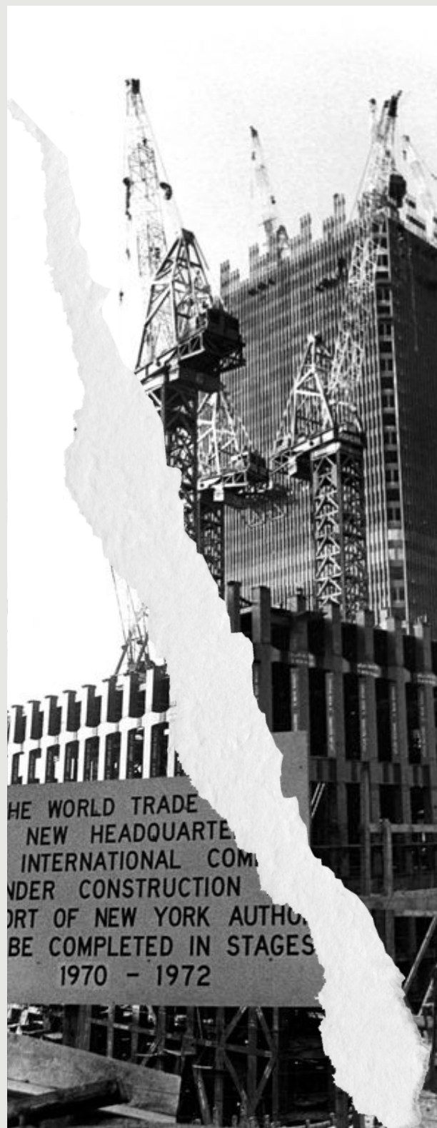
Torres gemelas. foro.megaconstrucciones.net
