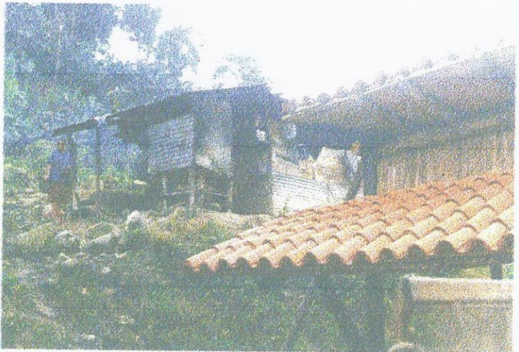
Figura 2. Vista del rancho y la nueva vivienda.
