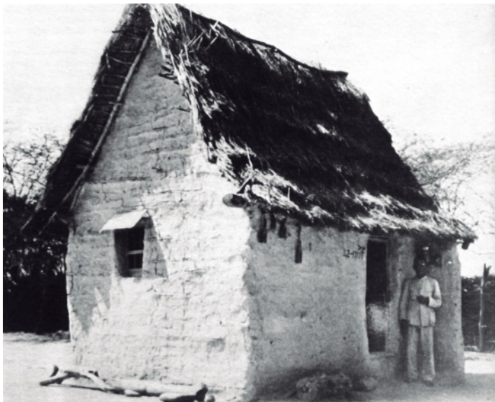
Foto 6: La "casa telar" de Elías García, tejedor quiboreño de lienzos de algodón. Nótese que en la pared frontal penden varias "quijadas" o poleas empleadas para el funcionamiento de los lizos. Junto a la puerta, el tronco de árbol empelado como "ayudante muerto". Mocundo, estado Lara.
