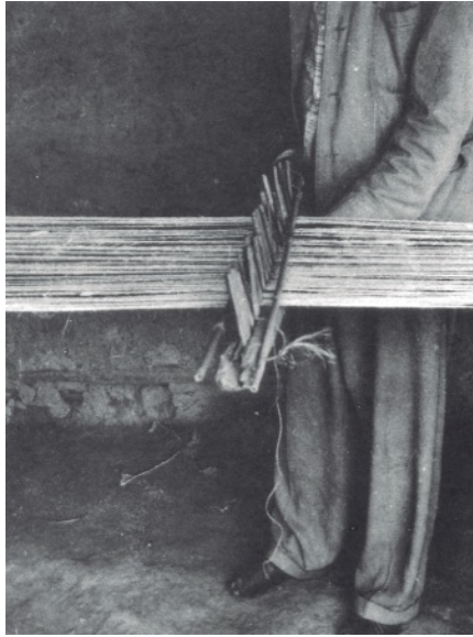
Foto 30: Empleo del rastrillo durante el montaje de la urdimbre en un telar Morón, estado Lara.
