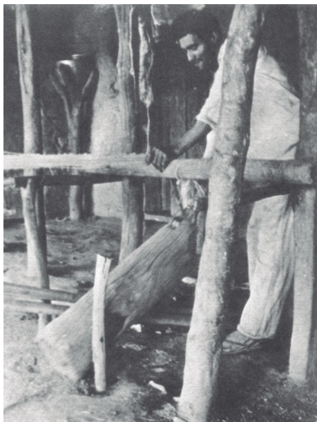
Foto 28: Eriberto Tovar, tejedor de bolsas de cocuiza, templando la urdimbre del telar con el "ayudante muerto". Morón, estado Lara.
