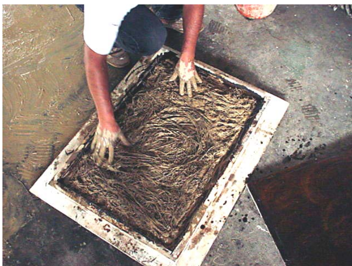
Figura 4. Fabricación de los Tableros.
