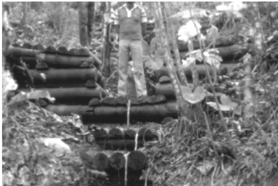
Foto 5. Dique de madera rolliza aplicado como medida preventiva en un torrente no activado de la micro-cuenca; fotografía tomada en 1981.
